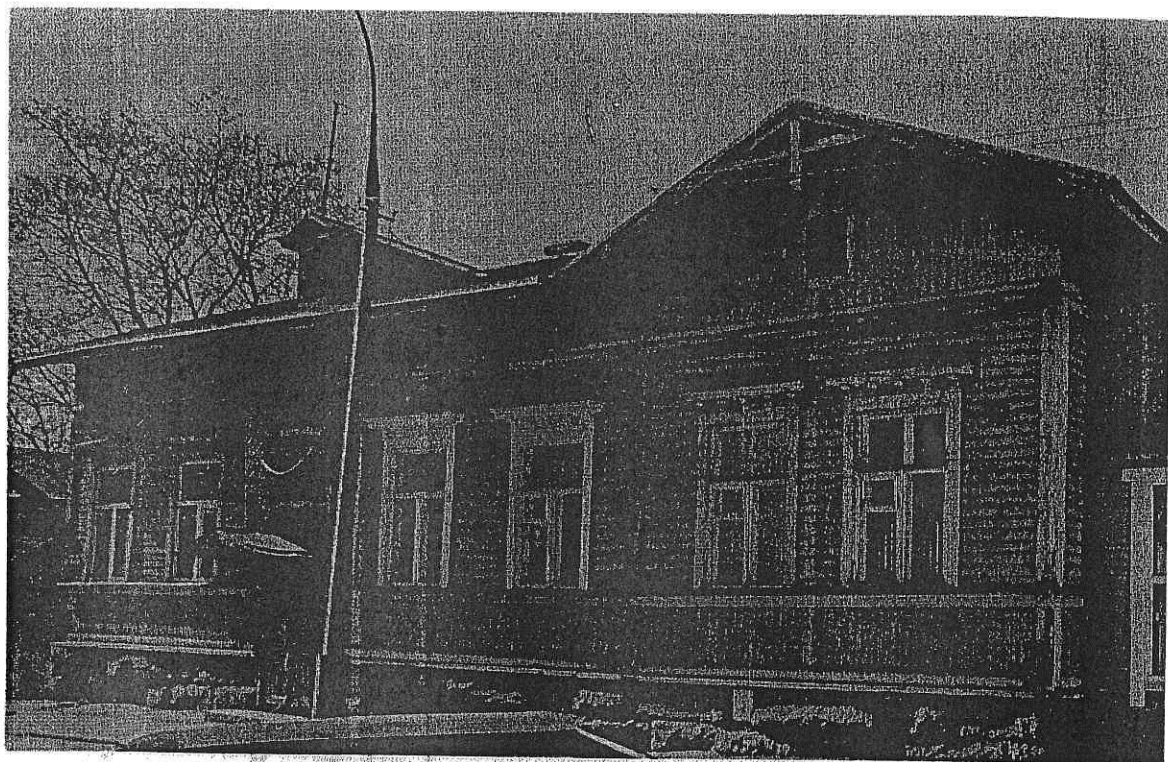
«Дом жилой» Республика Карелия, г. Сортавала, ул. Садовая, д. 11 Вид на главный фасад со стороны ул. Садовая. Дата: 2014 г.
